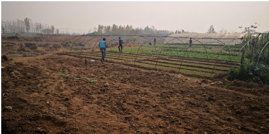
施工临时区复耕
