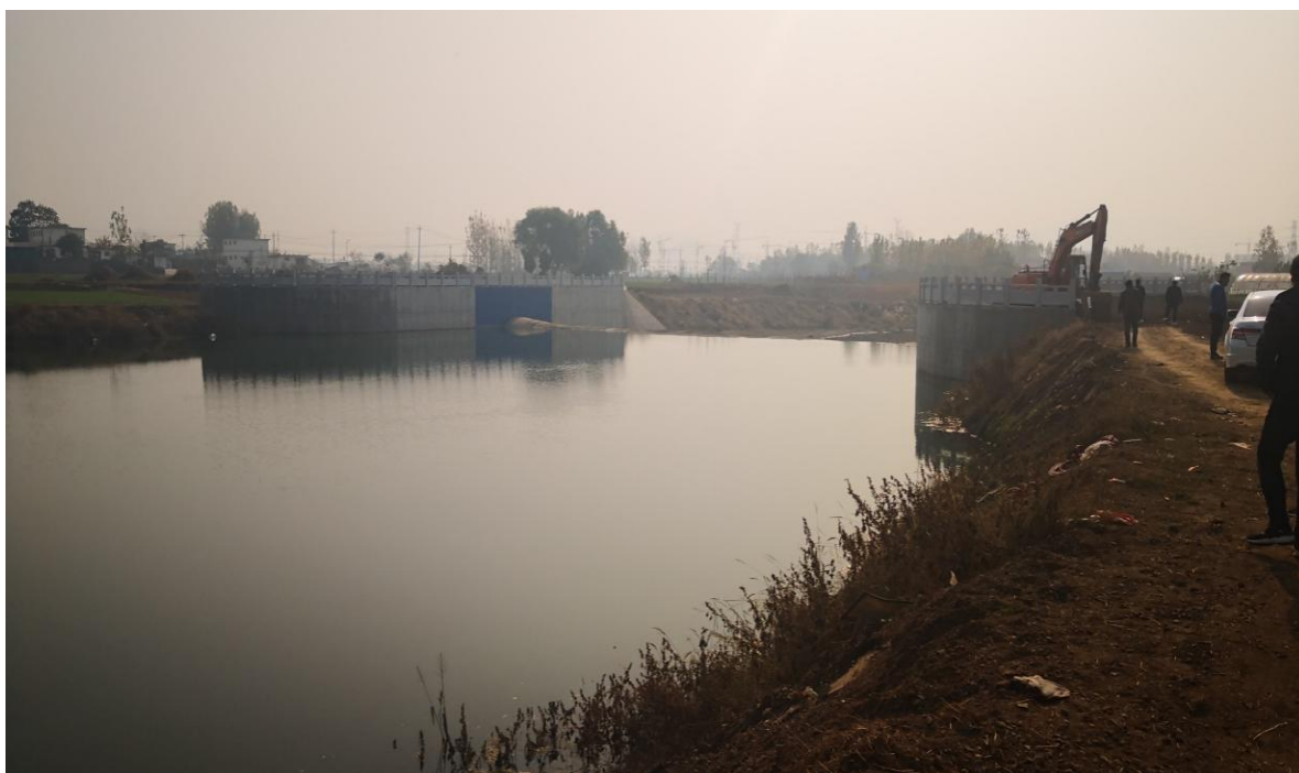
橡胶坝建成后
